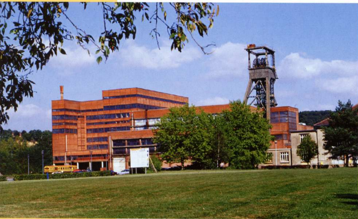
Petite-Rosselle, carreau Wendel - Photo CAUE de la Moselle
