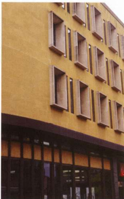
Le rez-de-chaussée s'estompe (pierre sombre). Forte présence du volume en pierres de Jaumont rythmé par des encadrements saillants en pierre blanche. Caisse d'Epargne à Metz.
