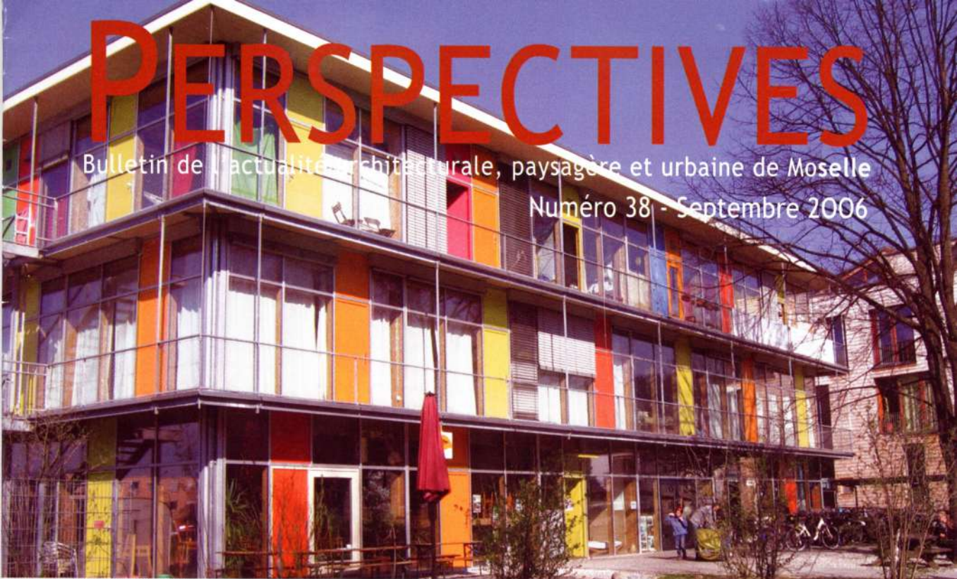
LOGEMENTS PASSIFS À FRIBOURG-EN-BRISGAU
